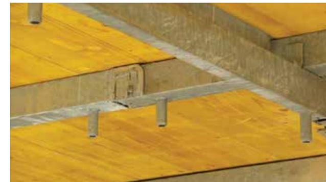
La simplicidad del sistema se basa en el tipo de unión entre los diversos elementos como el cabezal de la viga, que presenta un orificio de encaje en la barra de apoyo situada en la parte trasera de la viga.
