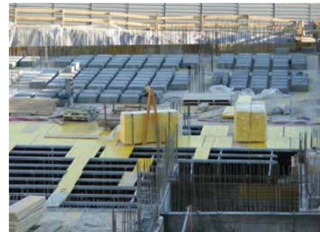
El sistema de encofrado recuperable Cofiber® se adapta con facilidad a cualquier tipo de losa de entpiso plana, formando un conjunto estructural sólido y resistente.
