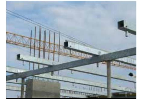
Las vigas de soporte secundarias se asientan sobre las vigas de montaje primarias, encajándose en el lugar apropiado.
